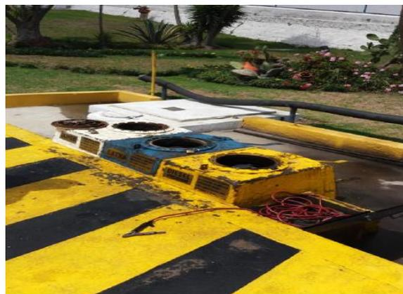
La descarga de combustibles desde los auto tanques hacia los tanques de almacenamiento subterráneos se realiza de forma directa, el combustible se descarga por gravedad a través de una manguera flexible de 4" con acoples herméticos que se ajustan a las bocas de llenado de cada uno de los tanques.
